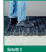
Schritt 3 Einrasten in das Sicherheitsverbundsystem
