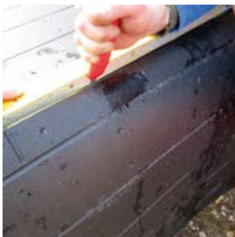
einfaches Zuschneiden mit Teppichmesser
