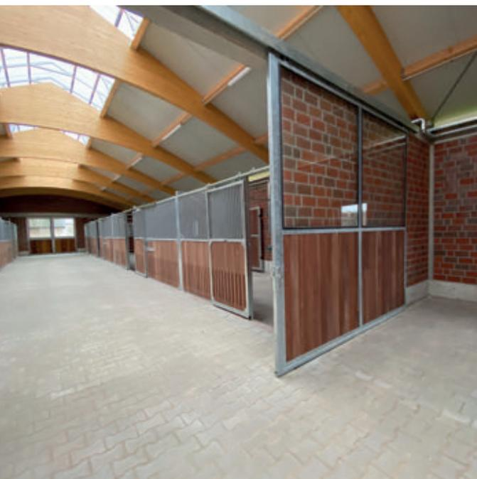
Stallschiebetor mit ESG-Glas, Holzfüllung Bongossi
