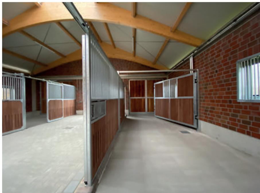
Frontwand Dorino, Holzfüllung Bongossi mit Lüftungsschlitzen
