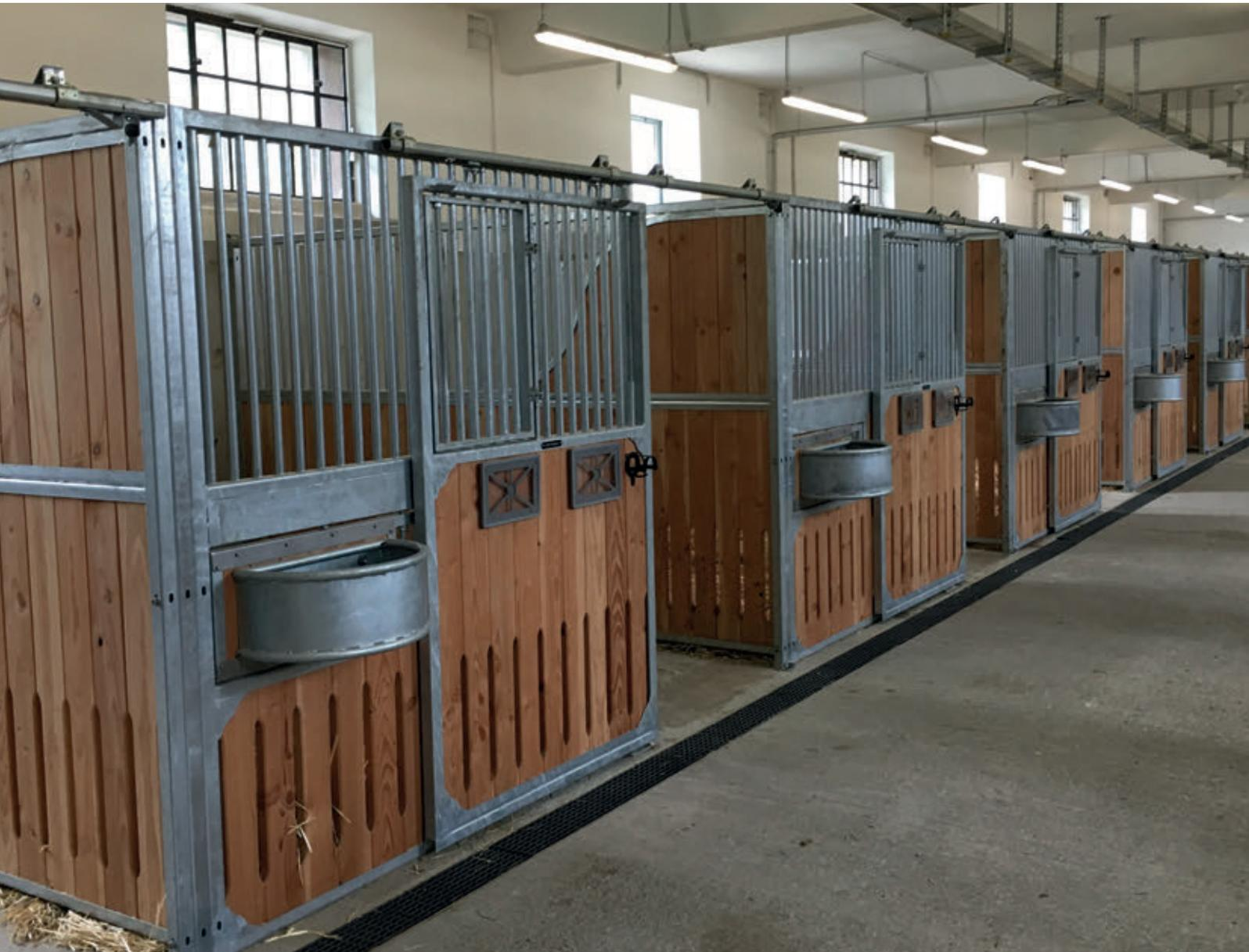
Frontwand Dorino mit Fensterklappe, Holzfüllung Douglasie inkl. Lüftungsschlitzen und Drehtrogvorrichtung
